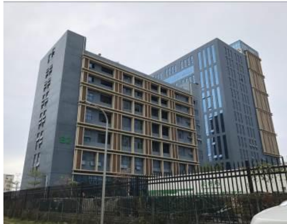
项目北面工业厂房
