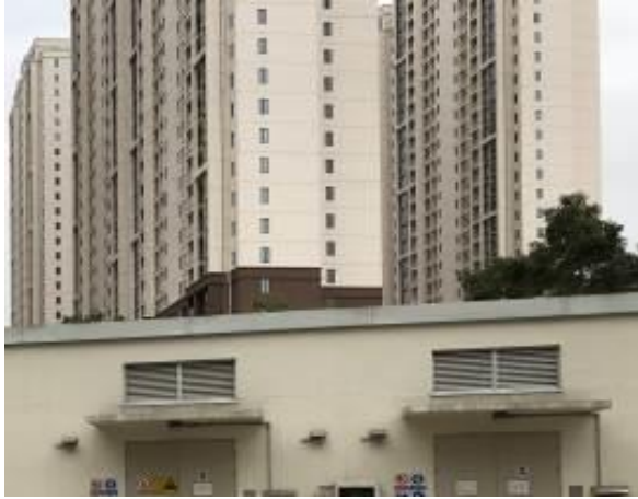
项目东面居民楼
