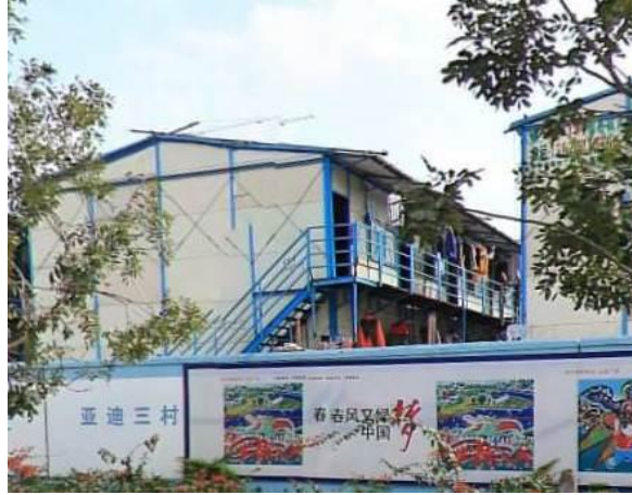
项目南面施工营地
