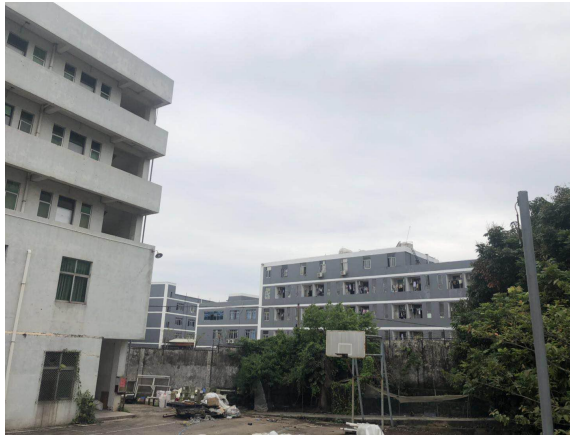
项目东面工业厂房
