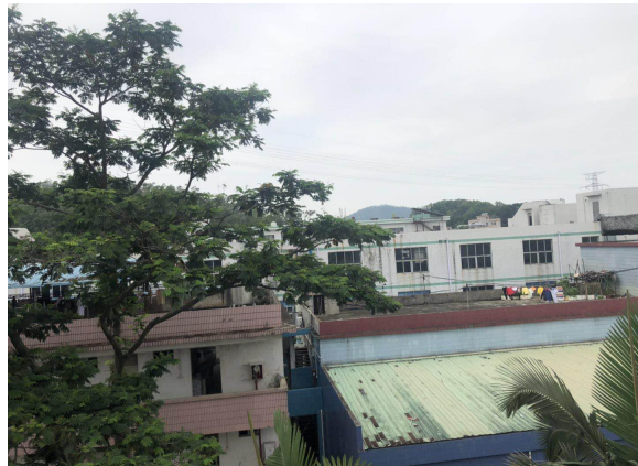
项目北面工业厂房
