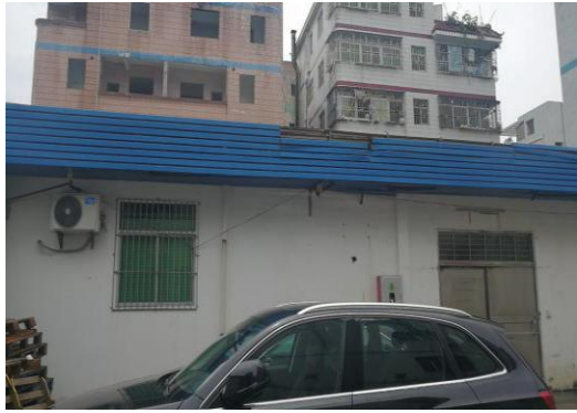
项目东面工业厂房
