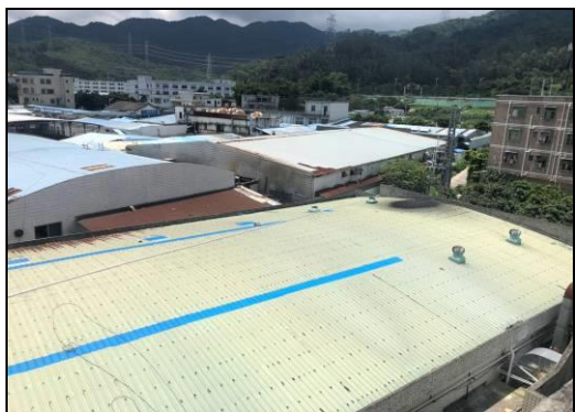
项目东南面工业厂房
