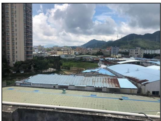
项目东北面工业厂房
