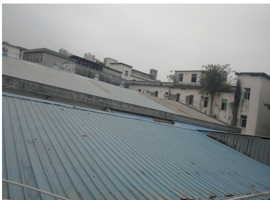
项目北面工业厂房
