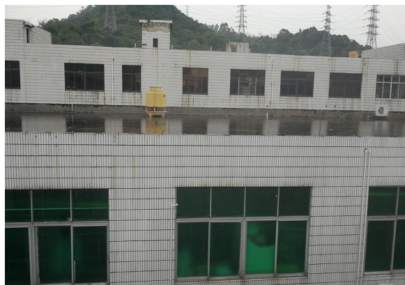
项目东面工业厂房
