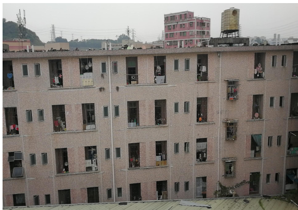
项目北面工业厂房
