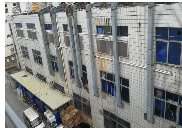
项目西面工业厂房
